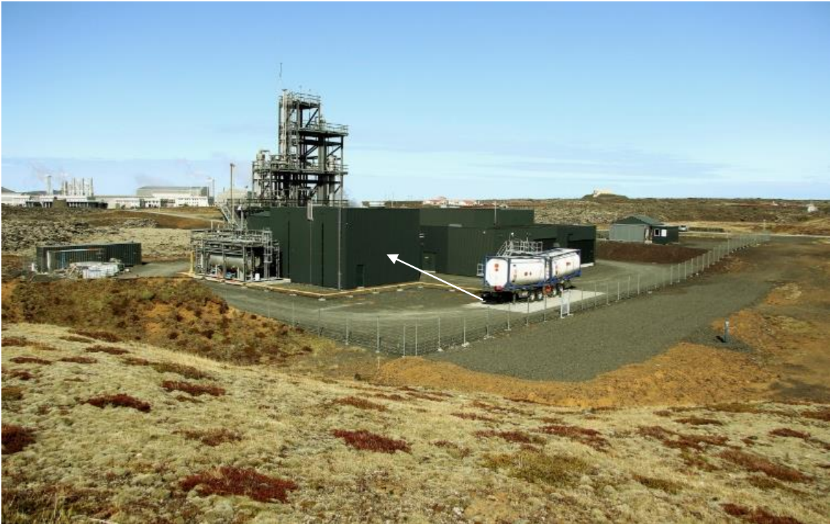
Mynd 10 Sýnir suður-og austurhlíð verksmiðju, aðkomuslóða - plan fyrir slökkvilið, og brunahana. Örin bendir á viðbyggingu gasþjöppuhúss til austurs. Mynd: Gunnar Þórðarson, 20.05.2016.
